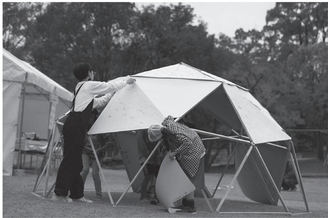
図5 ヒミツ基地の骨組みに貼り合わせる様子
