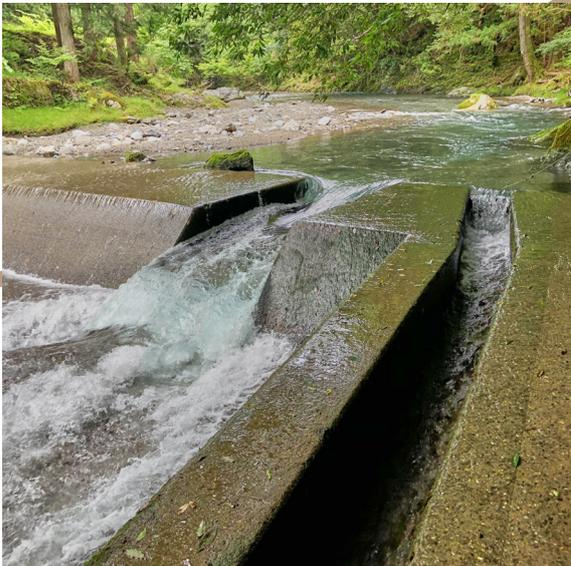
根尾水鳥地区の用水路の取水口は、集落より2Km程山奥の谷川に簡易ダムを敷設して水をせき止める形で敷設されている。近くにはそれ以前に利用していたと思われる太いポリエチレンパイプや鉄骨の台座の残骸も見られた。用水路の途中は何度か破損しては補修された痕があったが、コンクリートU字溝の中にポリエチレンパイプを入れているなど、水を通すという本来の用途が果たせるように、状況に合わせて柔軟な形で補修してきている。
