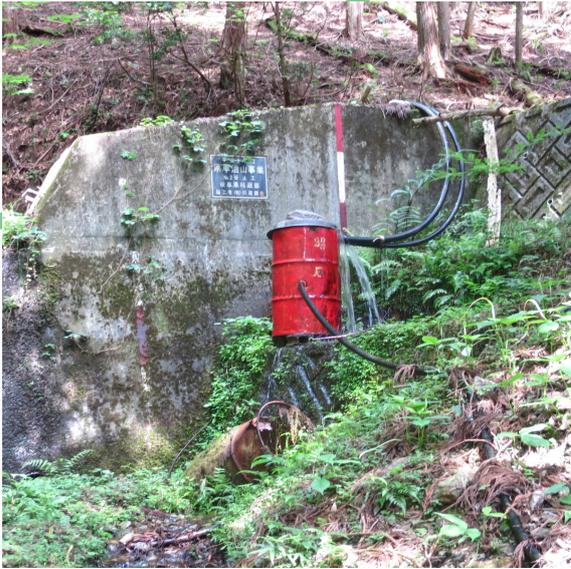
本巣市根尾水鳥地区では飲用および生活用水のパイプやタンクと田畑用の用水路が敷設されている。給水用のポリエチレンパイプや用水路のU字溝は既製のものが使われているが、ドラム缶を本来の用途とは違う貯水タンクに転用したりと、身近なものの加工や利用などいろいろ工夫もされている。これらの設備は台風や土砂崩れ、雪害等で破損して補修した形跡も見られるが、その際も身の回りにある様々な部品や素材を利用するなどして、大切に維持管理されている様子がうかがえる。
