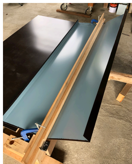
自作の折り曲げ機で屋根用に鉄板を加工
