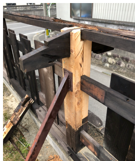
木塀の腐朽した屋根、腕、柱を修復
